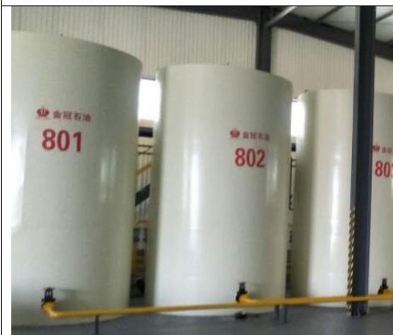
车间罐区及地面硬化防渗
