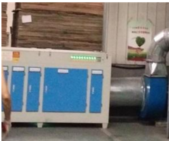
图 4-1 多层车间 1#~4#热压机光催化氧化装置
