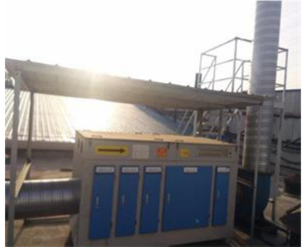
图 4-6 中段 1#、2#、3#热压机光催化氧化装置
