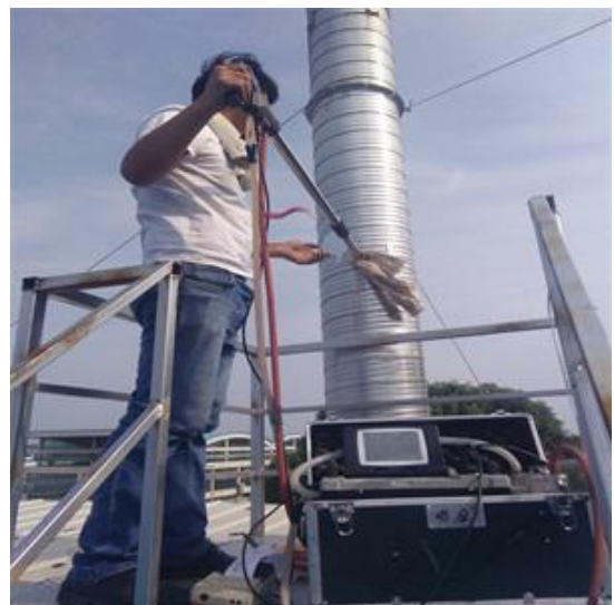
图 4-18 多层 8#~10#热压机废气采样平台
