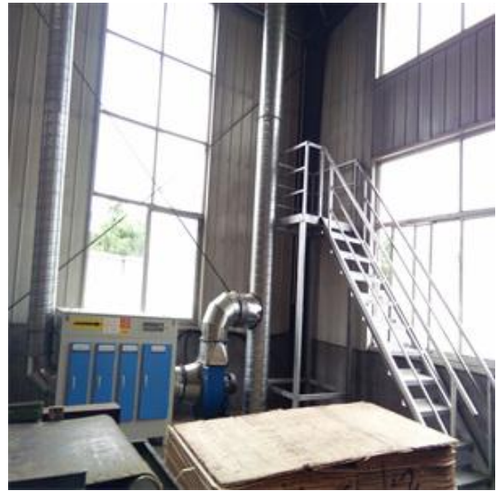
图 4-16 涂胶线废气采样平台
