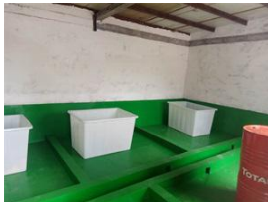
图 4-12 危废库内部防渗
