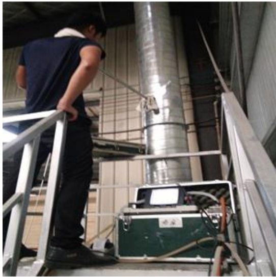
图 4-15 多层车间 1#~4#热压机废气采样平台
