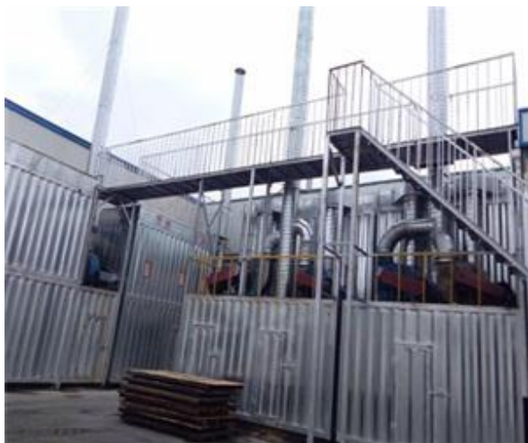
图 4-9 砂光机、拉丝机布袋除尘器
