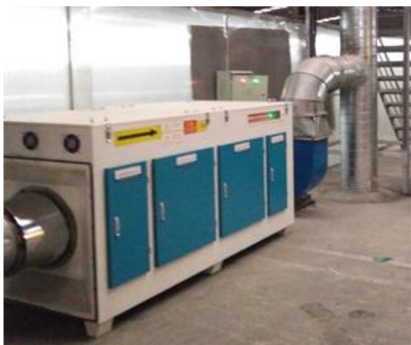
图 4-3 基板车间涂胶工序光催化氧化装置
