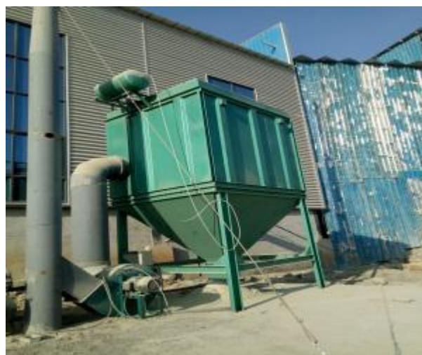
图 3-3 1#锤式破碎机脉冲布袋除尘器
