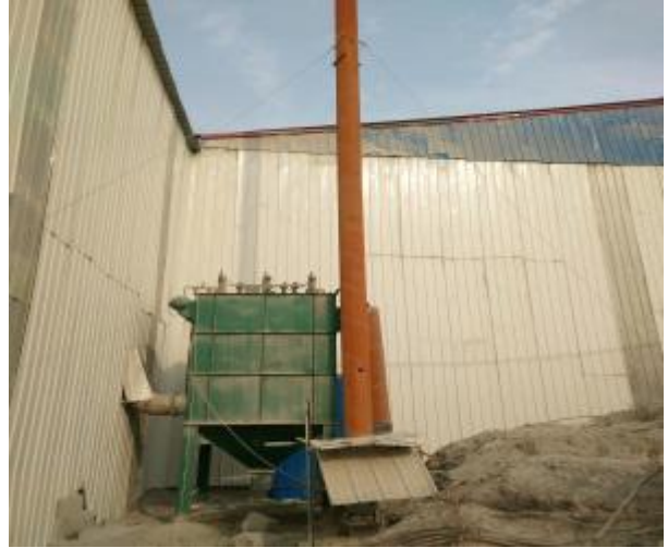
图 3-5 筛分机布袋除尘器
