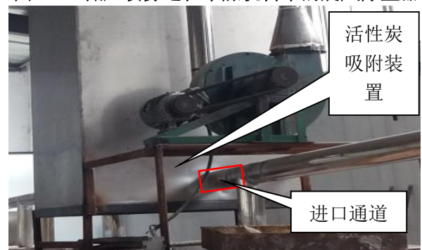
图 9-4 回收料排胶工序活性炭吸附装置
