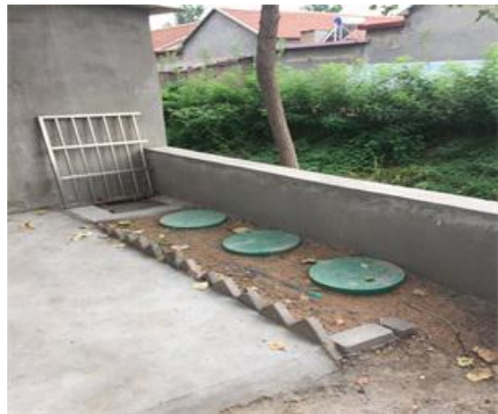
图 4-2 一体化污水处理设备
