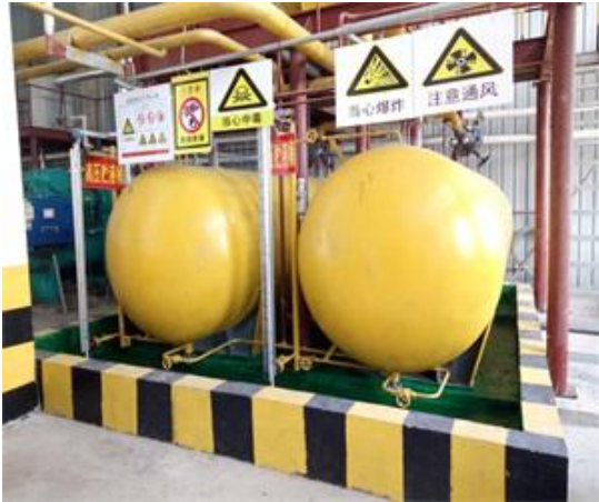
图 4-13 罐区围堰
