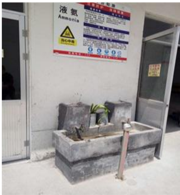
图 4-16 地下水监控井设置情况
