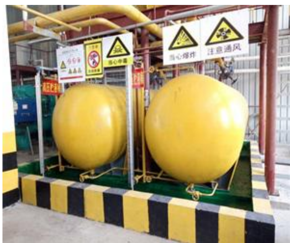
图 3-11 液氨储罐
