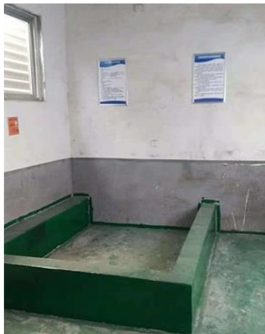
图 4-9 危废暂存处内部
