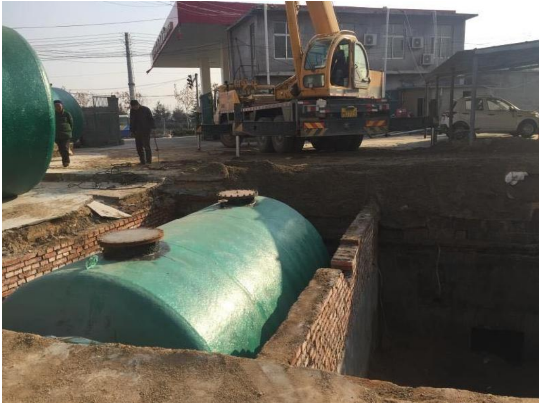
附件 13 双层油罐更换施工照片
