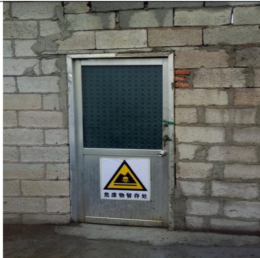
图 4-5 危险废物暂存间外貌
