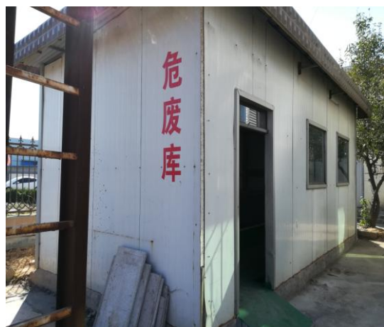
图 1 危废库外部整改前
