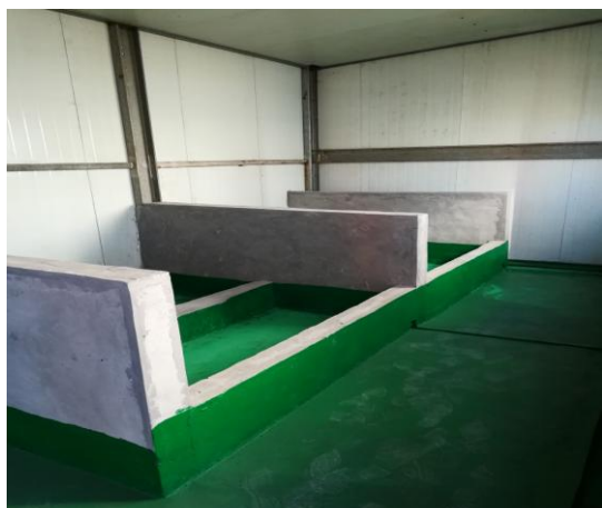
图 3 危废库内部整改前
