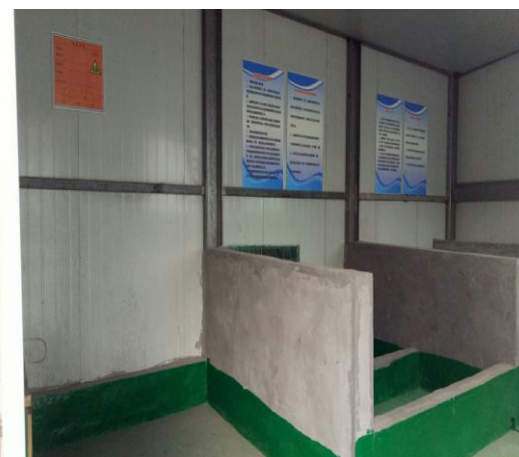
图 4 危废库内部整改后
