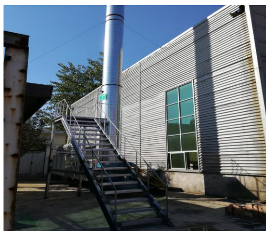
图 4-6 喷漆车间废气排气筒
