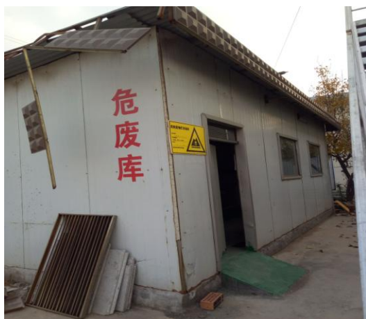
图 4-7 危险废物暂存处
