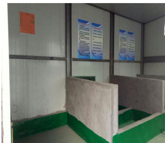
图 4-9 危废暂存处内部
