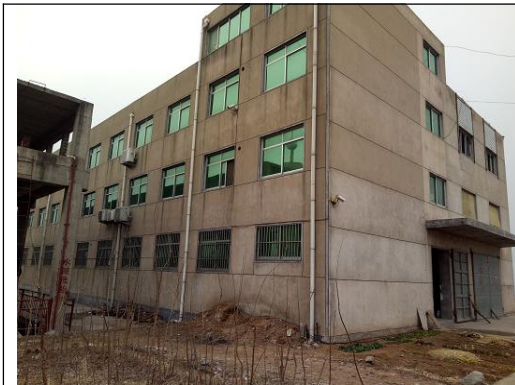
图 4-4 厂房建设情况
