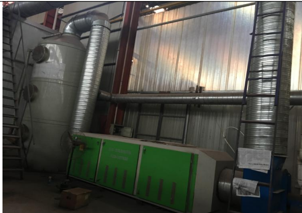
图 4-3 喷淋塔+光催化氧化装置
