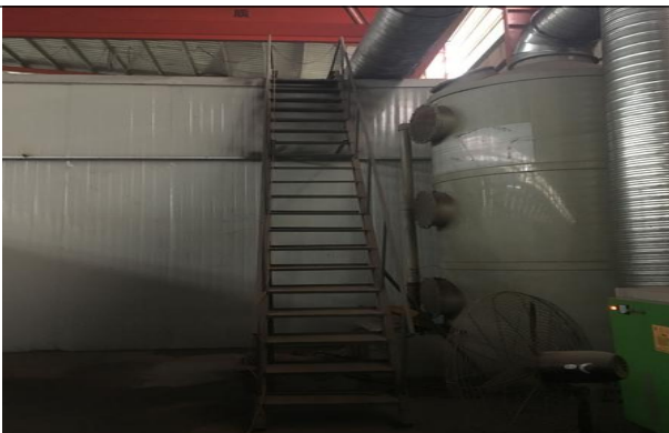
图 4-11 地面至喷漆房之间的斜梯
