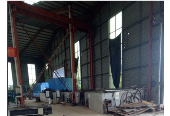
图 4-10 一般固废暂存处
