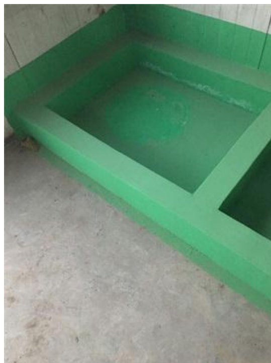
图 4-5 危废库内部防渗
