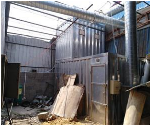
图 4-3 砂光机用脉冲布袋除尘器
