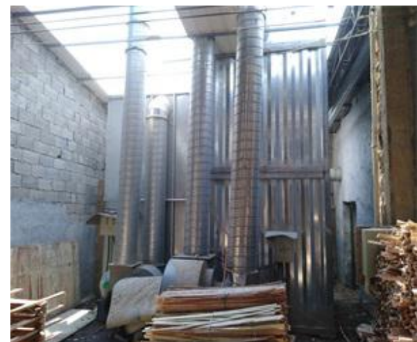
图 4-4 锯边、拼板锯断、抛光工序脉冲布袋除尘器
