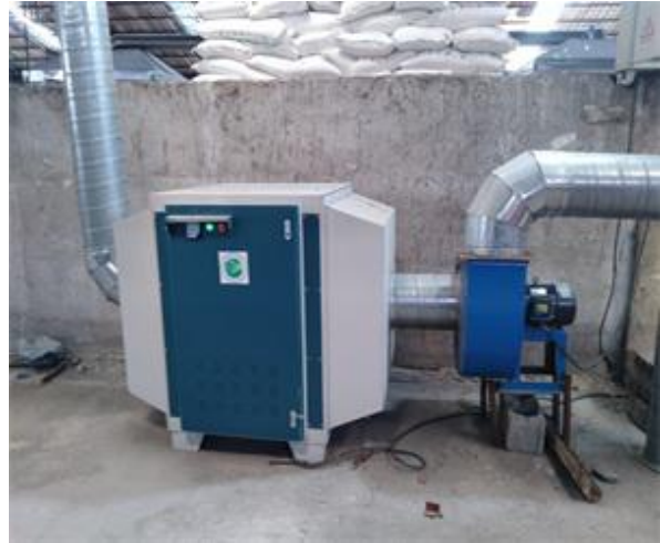
图 4-2 涂胶机用光氧催化装置
