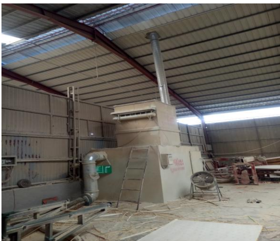
图 4-6 布袋除尘器废气标识牌
