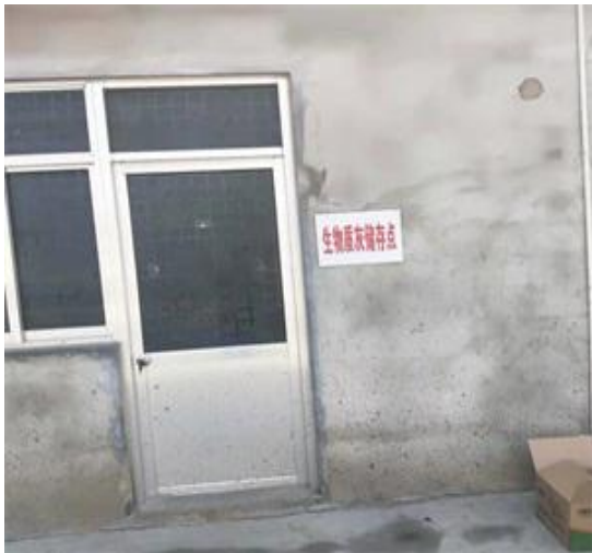
图 4-11 生物质锅炉灰渣暂存处
