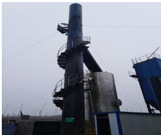
图 4-12 熔铸炉废气采样平台
