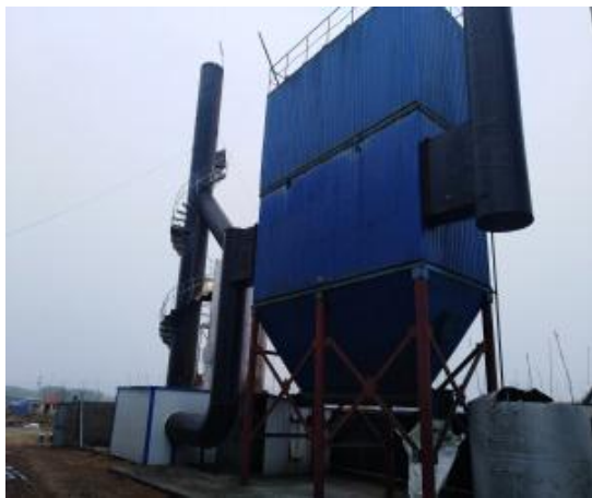
图 4-5 脉冲布袋除尘器
