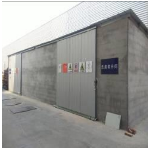
图 4-19 危险废物暂存区
