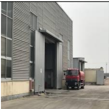
图 4-25 本项目消防栓、消防车
