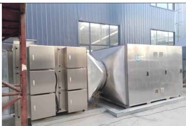
图 4-7 内胎车间低温等离子+UV 光氧设备
