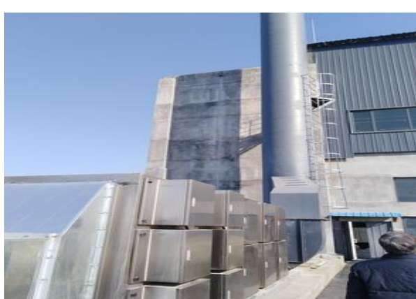
图 4-11 密炼车间低温等离子+UV 光氧设备
