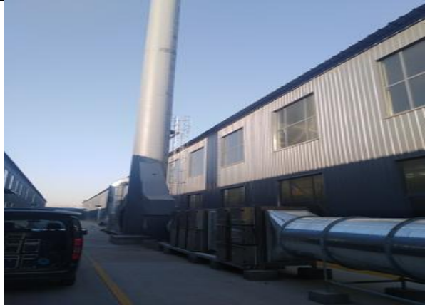
图 4-15 成型车间(东)低温等离子+UV 光氧设备
