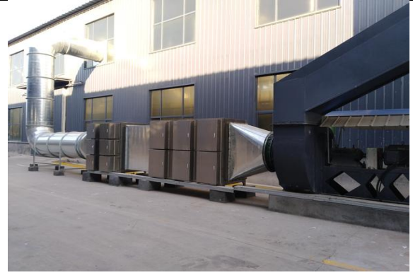
图 4-14 成型车间(西)低温等离子+UV 光氧设备
