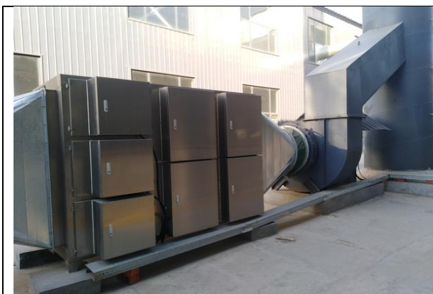
图 4-5 压延压出车间低温等离子+UV 光氧设备
