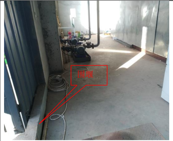
图 4-22 芳烃油罐车间围堰
