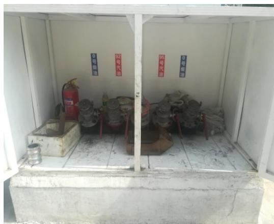
图 4-2 卸油口及一次油气回收系统
