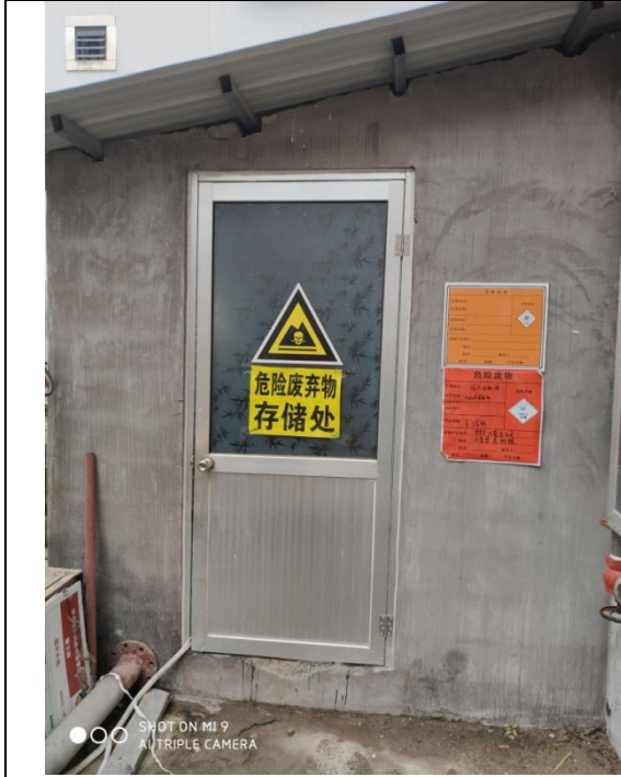
图 4-3 危险废物暂存区建设情况一
