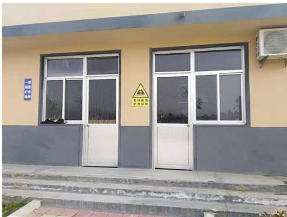
图 4-11 危废库及一般固废暂存处
