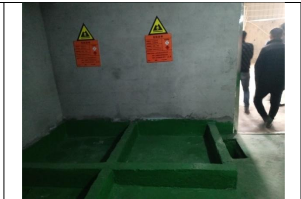
图 4-10 危险废物暂存处内部
