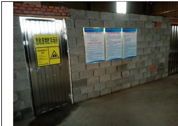
图 4-9 危险废物暂存处外部
