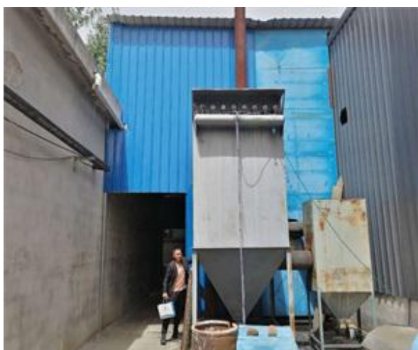
图 4-3 沉降室+脉冲布袋除尘器
