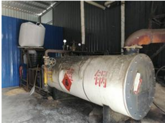
图 3-3 42 万大卡生物质导热油锅炉
