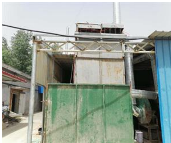
图 4-2 脉冲布袋除尘器
