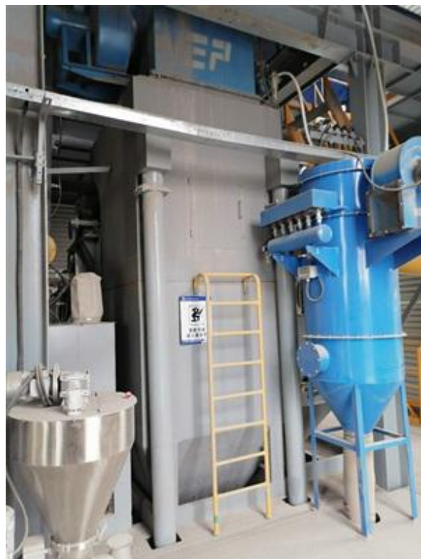
图 4-2 脉冲布袋除尘器
