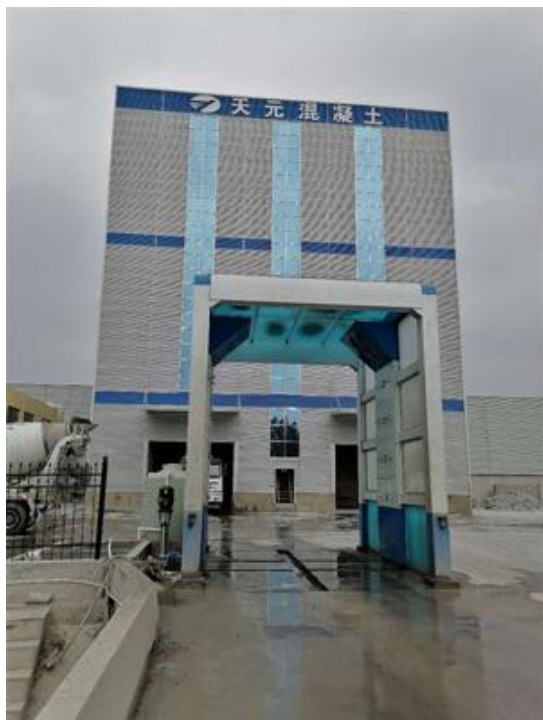
图 3-3 混凝土搅拌站
