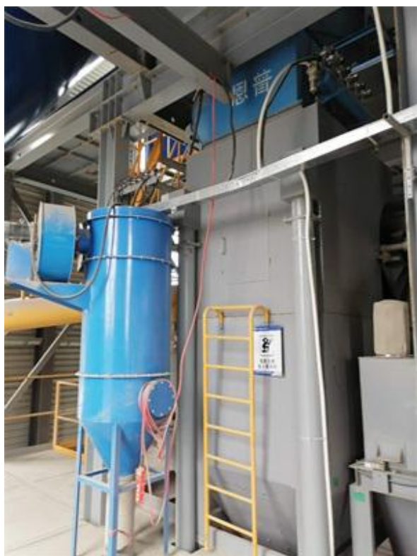
图 4-1 脉冲布袋除尘器
