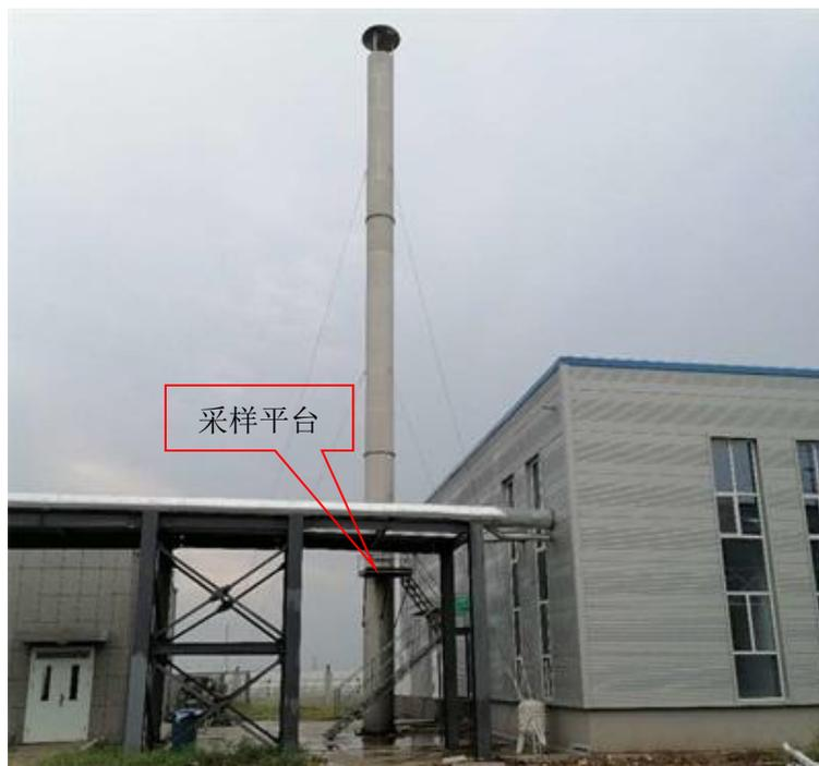
图 4-2 锅炉废气排气筒
