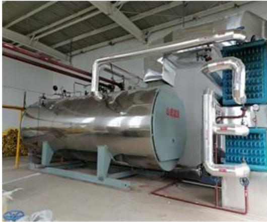
图 3-2 蒸汽锅炉
