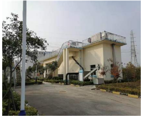
图 3-4 细格栅、曝气沉砂池
