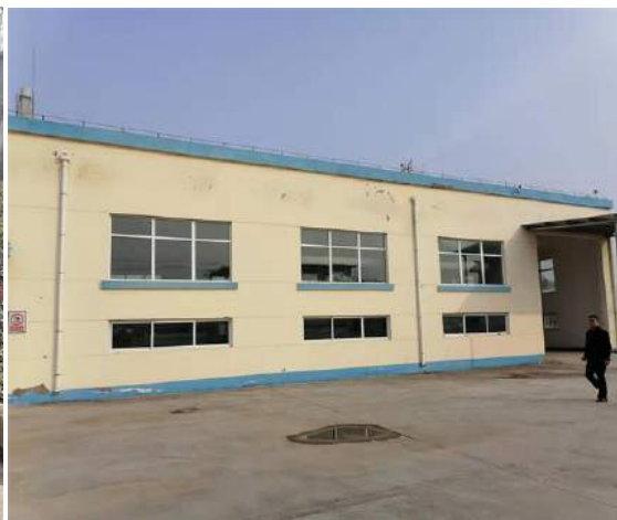
图 4-10 污泥脱水车间及污泥贮存间
