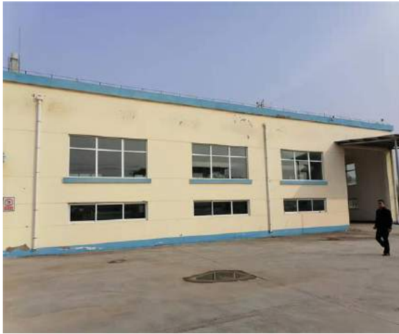
图 3-9 污泥脱水车间
