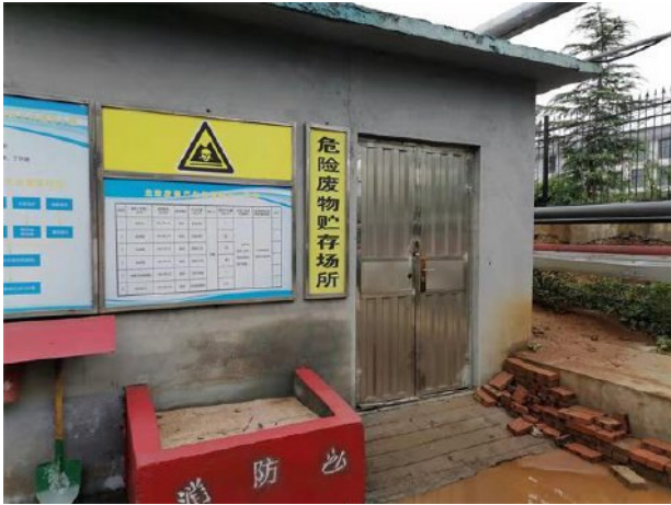
图 4-13 危险废物暂存处
