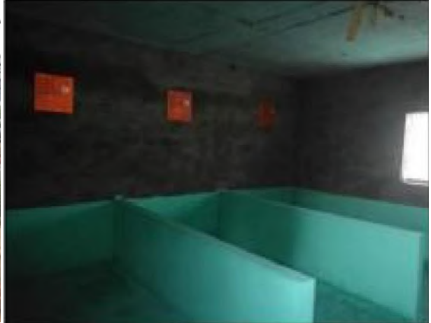
图 4-14 危险废物暂存处内部
