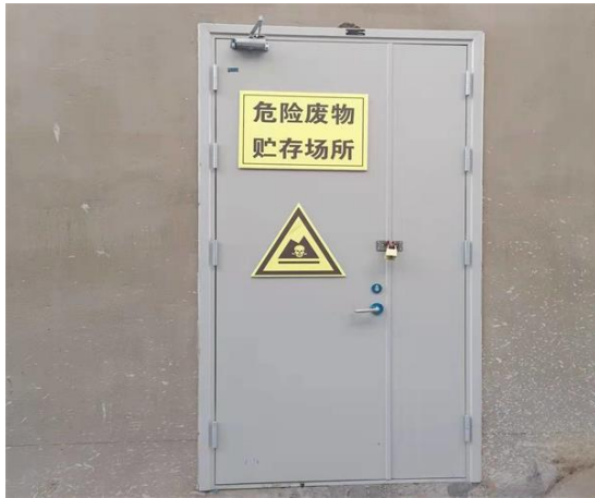
图 4-8 危险废物暂存处
