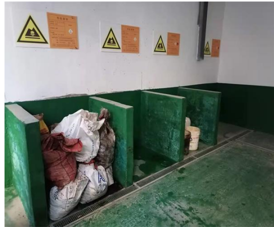
图 4-9 危险废物暂存处内部隔断
