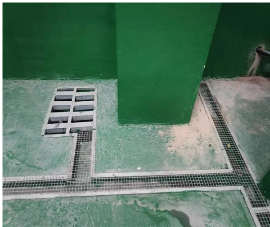
图 4-10 导流槽、集液槽
