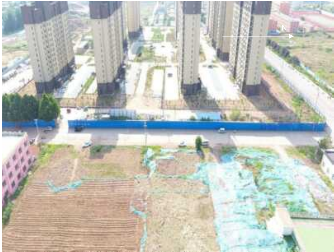
图 3-10 地块西部航拍图片
