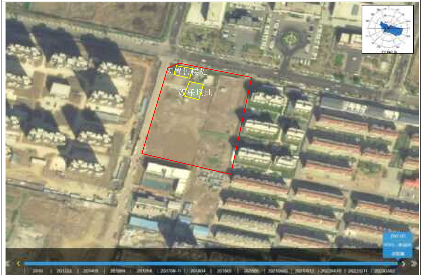
拍摄于 2023 年 03 月，与 2022 年相比，地块内鑫星·锦悦施工完成，工棚拆除，售楼处闲置。其他未有变化
