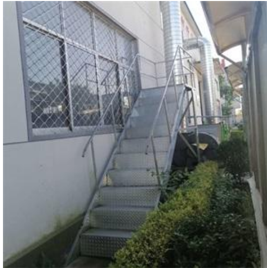
图 4-5 1#车间注射线有机废气采样平台
