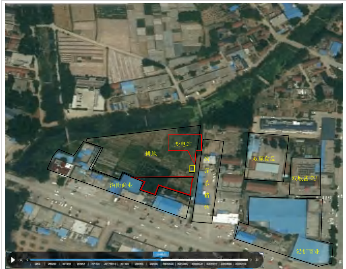
拍摄于 2020 年，地块北侧为耕地、果园和变电站；地块以东为废弃杀猪站（2019 年废弃，现仅剩南部一冷库为鲁双生鲜超市所用）、沿街商业、沂南县双赢食品有限公司和双墩酱菜厂；地块南侧为林地、耕地和沿街商业；地块西侧为耕地、林地和沿街商业。
