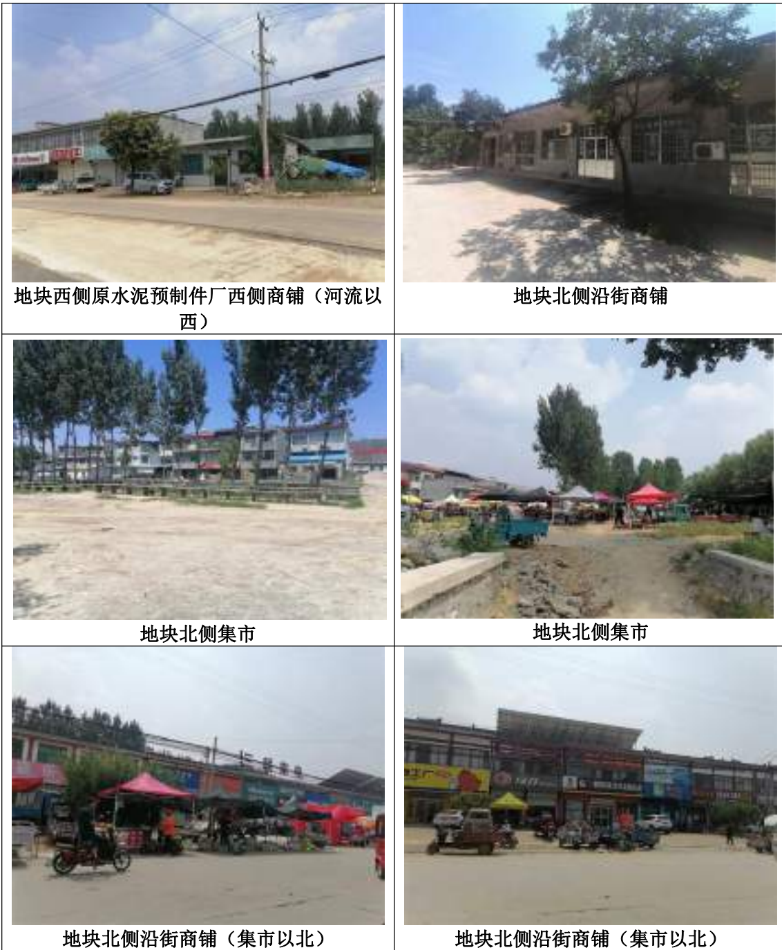
图 3-10 相邻地块现状照片
