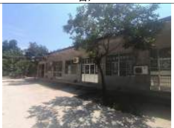
地块北侧沿街商铺
