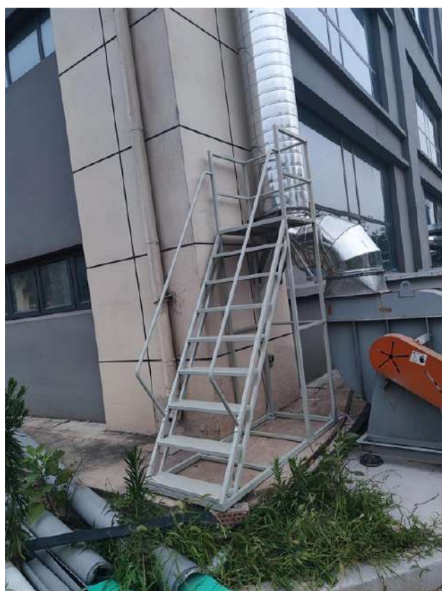
图 4-4 废气采样平台
