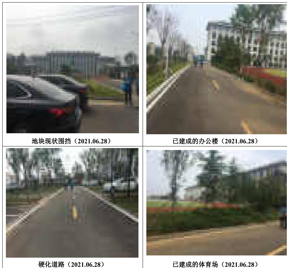
图 4-1 现场踏勘图片
