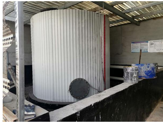
图 3-17 硫酸储罐
