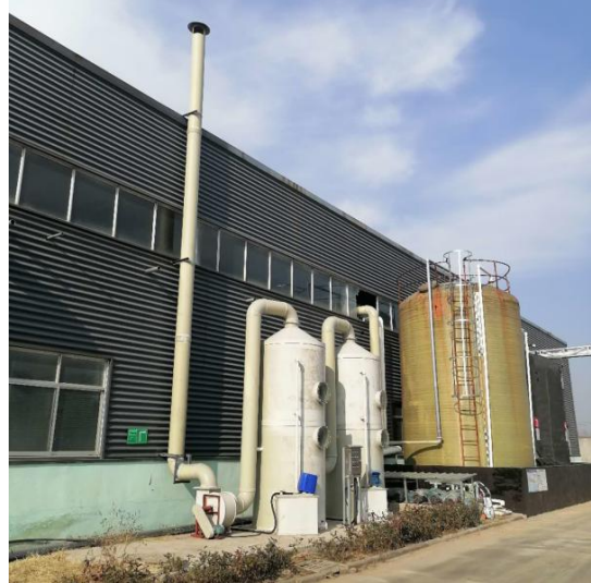
图 4-13 废气排气筒
