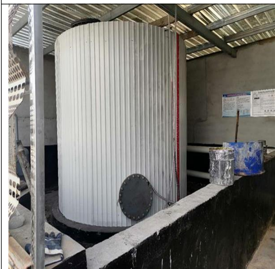
图 4-10 罐区围堰
